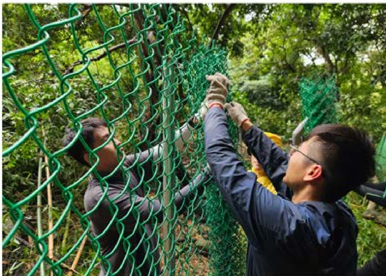
圖說 | 志工進行7尺高的鐵網連接
