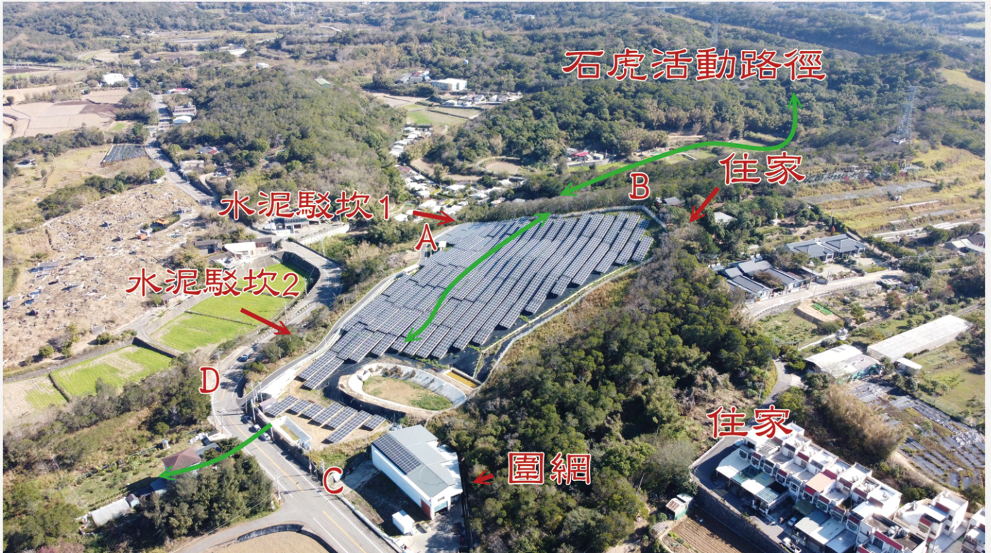
圖② 普登通霄北勢窩光電廠，聲稱「有拍到石虎，保育有成」，但這裡本來就是石虎必經之路，被開發的光電場無法提供石虎躲藏與庇護（拍攝/製圖 李環泓）
