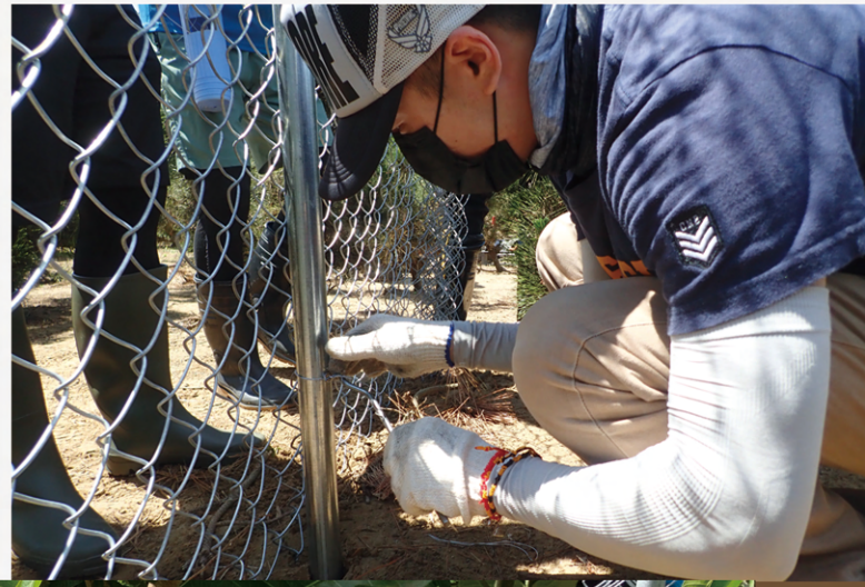
圖說 | ④ 志工將鐵網固定到鐵桿上 ⑤ 幫忙銜接鐵網（攝/曾振邦）
