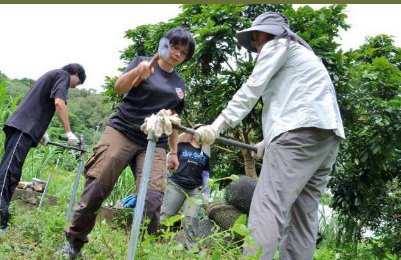
圖說：③初期使用鐵槌打樁，耗費時間與人力／④改用電槌打樁，大幅加快雞舍搭建速度
